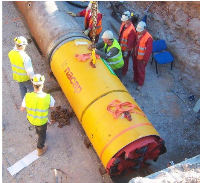
Figura 6. Comienzo de la operación de microtunelación por medio de tuneladora. Fuente: Wood, 2024.
