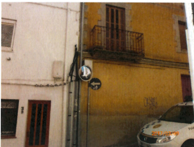
Travessia Raval amb carrer Petit Raval
