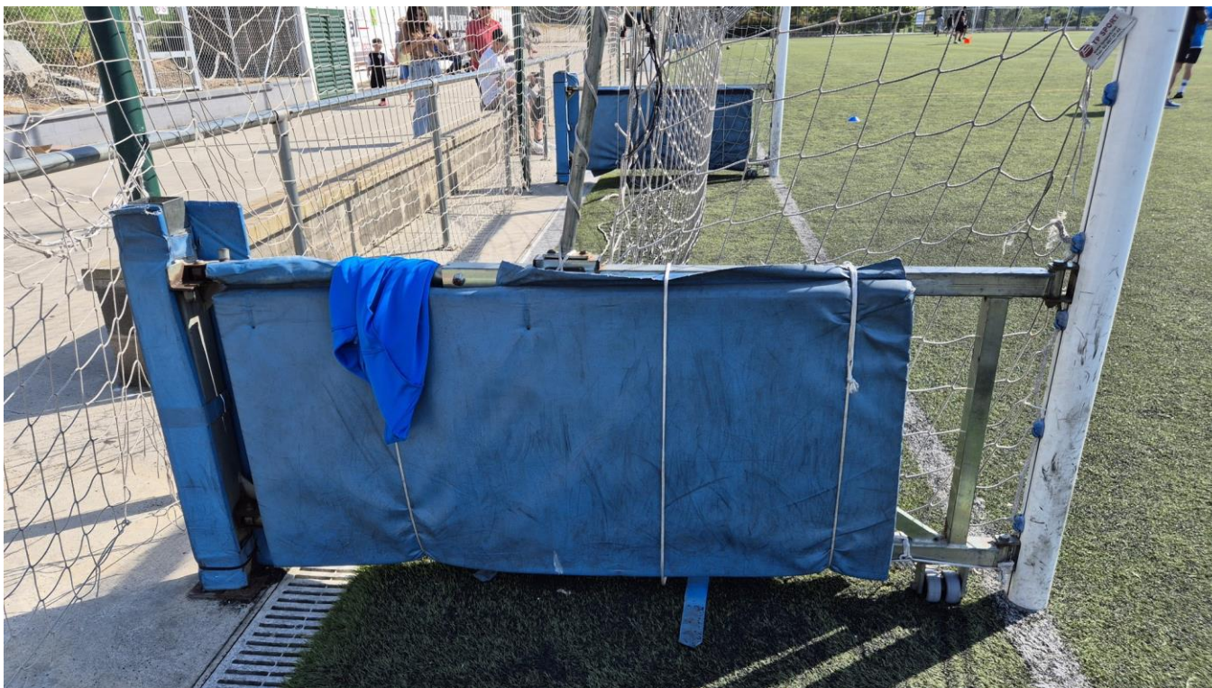
Detall de l'estat de les proteccions
