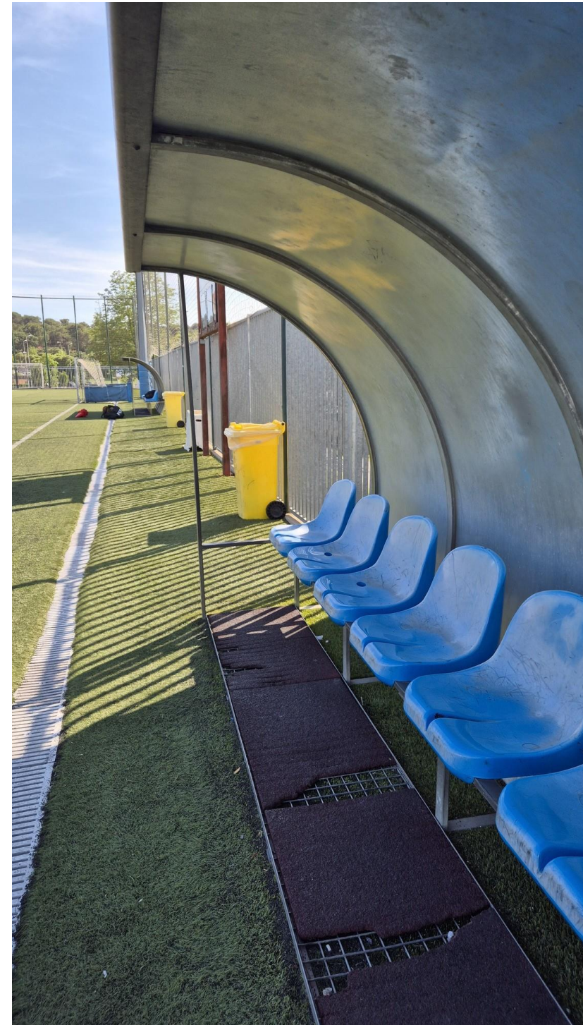
Detall de l'estat de les banquetes que caldrà incorporar proteccions laterals
