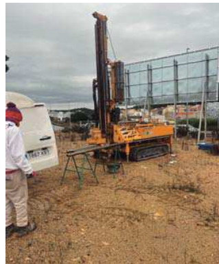
Execució dels assaig de penetració P1 i P2, i central de dades de l'equip de pressiometria Ménard.
