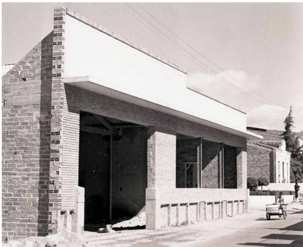
▲ Façana en construcció del magatzem de Coca-Cola a l'Avda. Martínez Anido (actualment c/ Jaume I). Fons Gelabert Rigau (AMBL)
