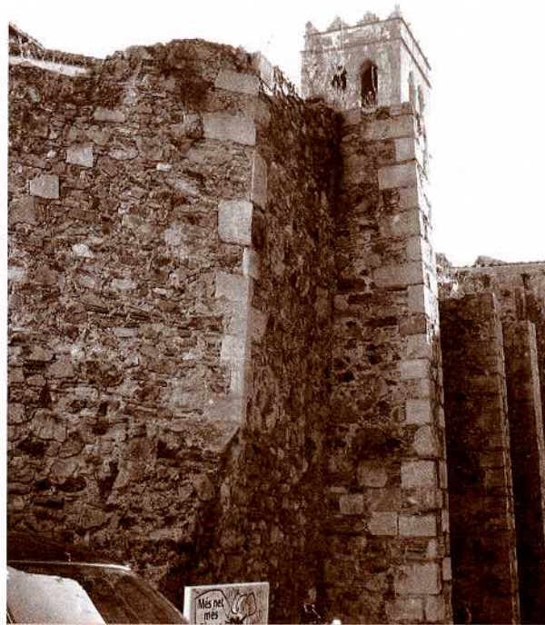
L'àbsida, els contraforts i el mur exterior de la Capella dels Dolors es va construir amb la pedra aprofitada de l'antic cementiri.
