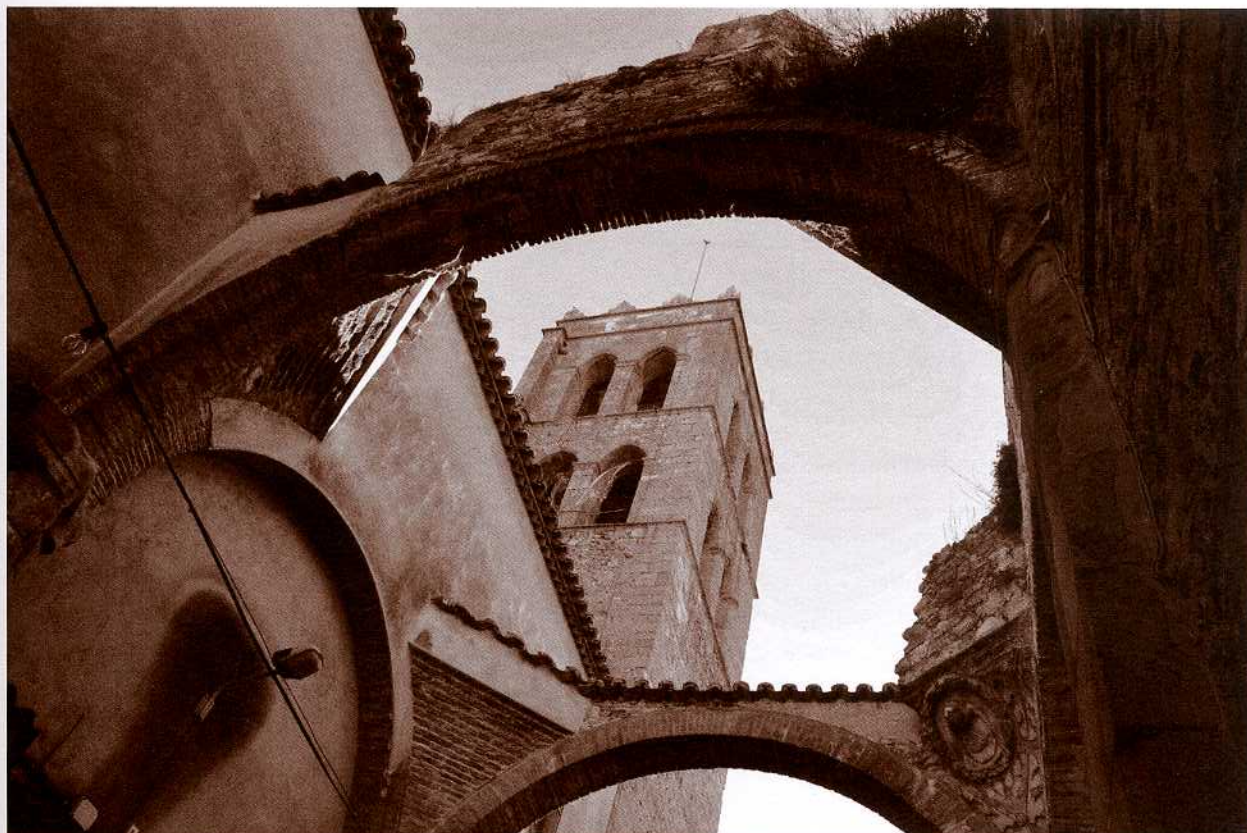
Petxines i voltes que sostenien la cúpula del Santíssim Sagrament.
