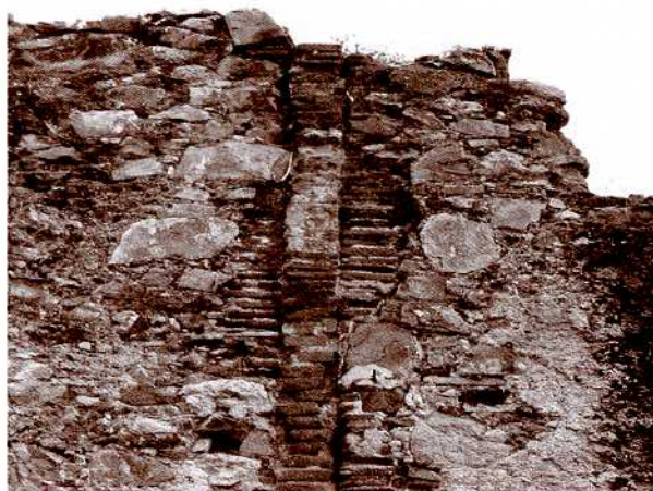
Mur de pedra amb fileres de totxanes que sostenien l'arrancada de les voltes de la capella.
