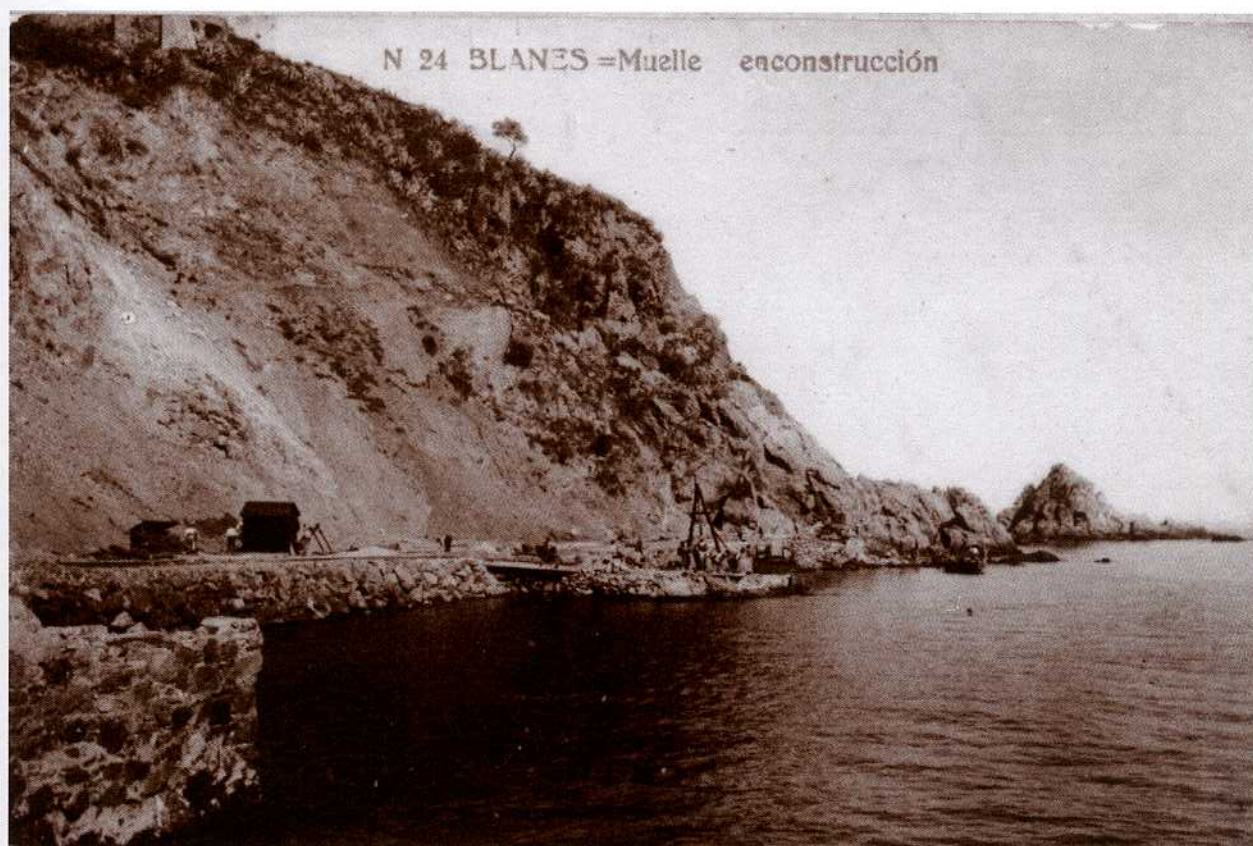
Començament de les obres. 1914 (AMBL)
