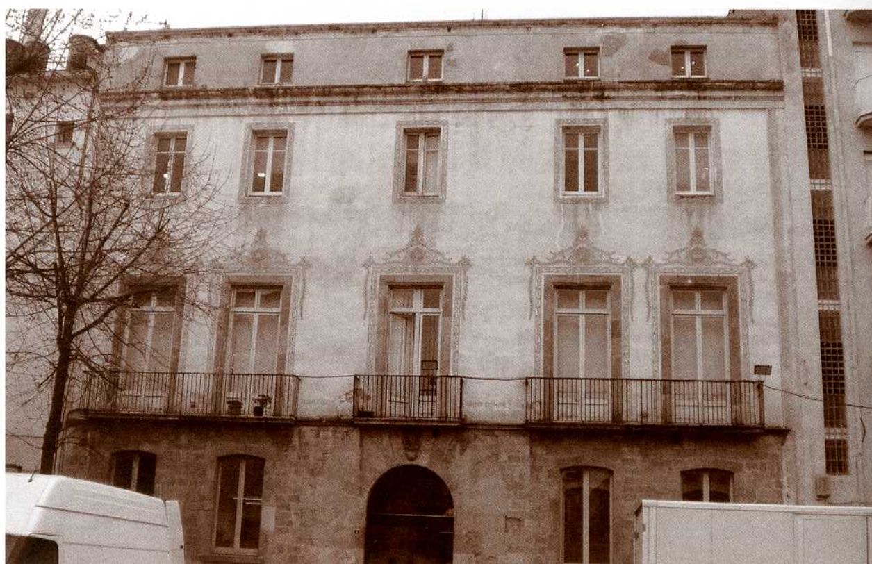
La façana abans de la restauració
