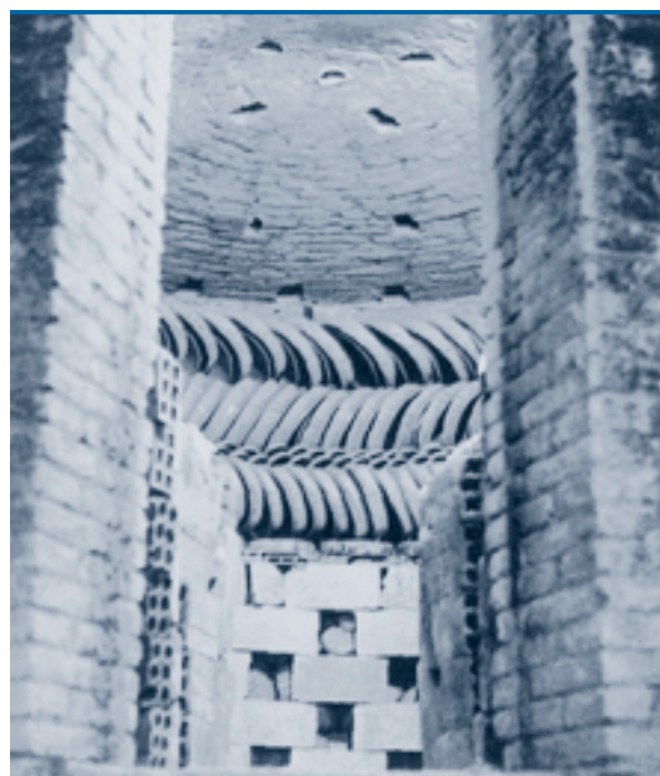
Interior d'un forn de terrissa.
