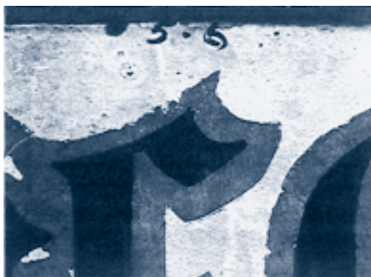
Detalls de marques d'identificació dels panells i exemple de vidre rosegat a causa dels cargols del bastidor.
