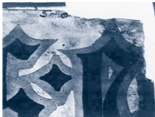
Detalls de marques d'identificació dels panells i exemple de vidre rosegat a causa dels cargols del bastidor.
