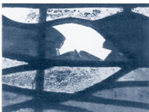
Detall del vidre trencat i del canviat.
