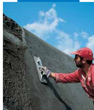
Acabado de Mapegrout T40 con fratas
