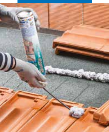
Encolado por puntos de tejas
