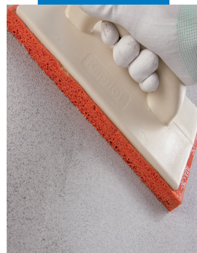
Acabado del enlucido con frías de esponja
