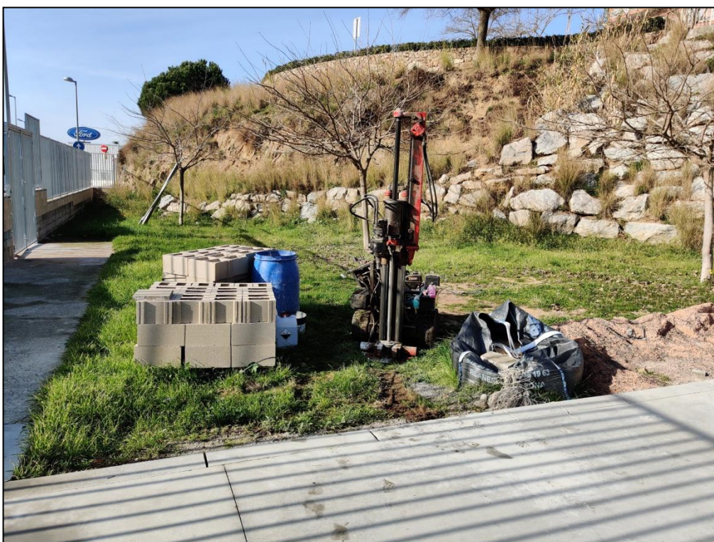
Vista penetròmetre nº 4
