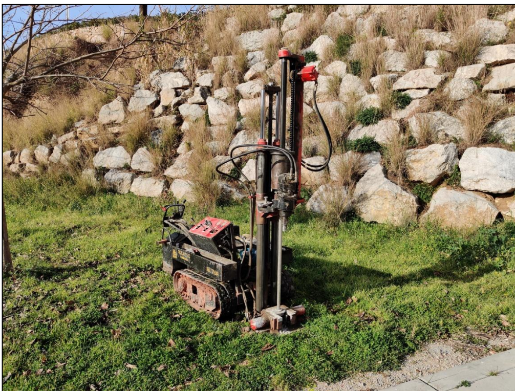
Vista penetròmetre nº 3
