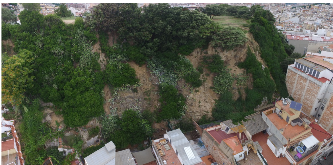
Imatge 4-1.- Zona 1 del vessant a estabilitzar
