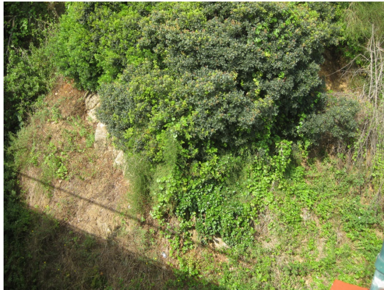
Imatge 4-2.- Zona 2 del vessant a estabilitzar
