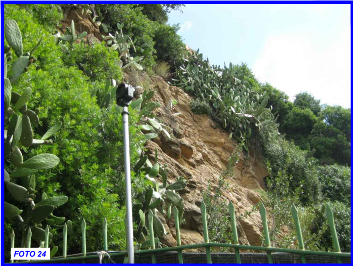
VESSANT MES PROPER AL PATI INTERIOR (S'AUGUER Nº14)
