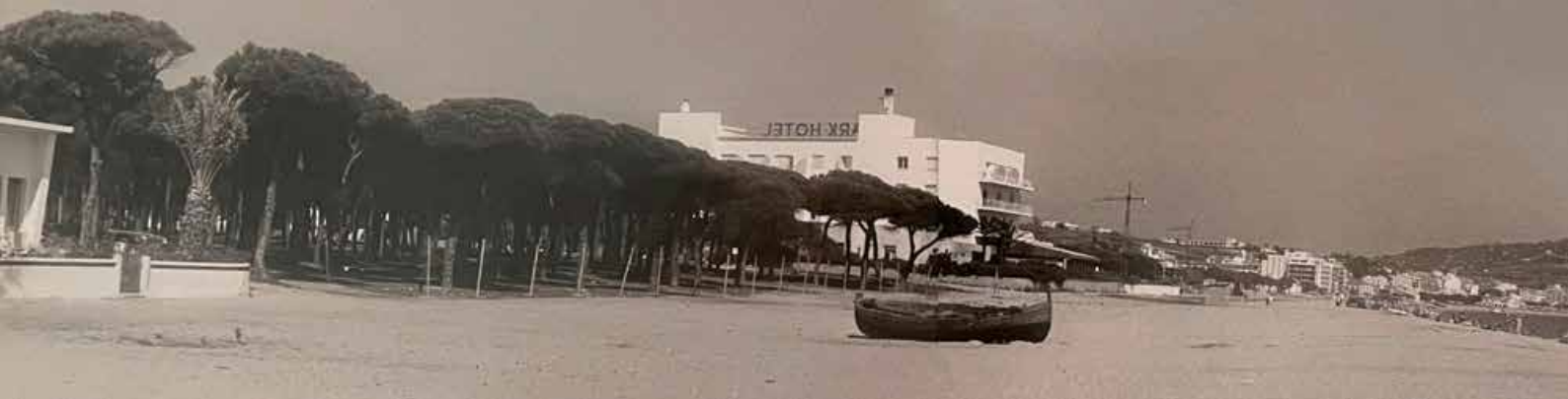
▲ La platja de s'Abanell a principis dels anys seixanta, amb els bungalows a l'esquerra i el Park Hotel al centre. Foto: Ines Wegge-Schatz.
