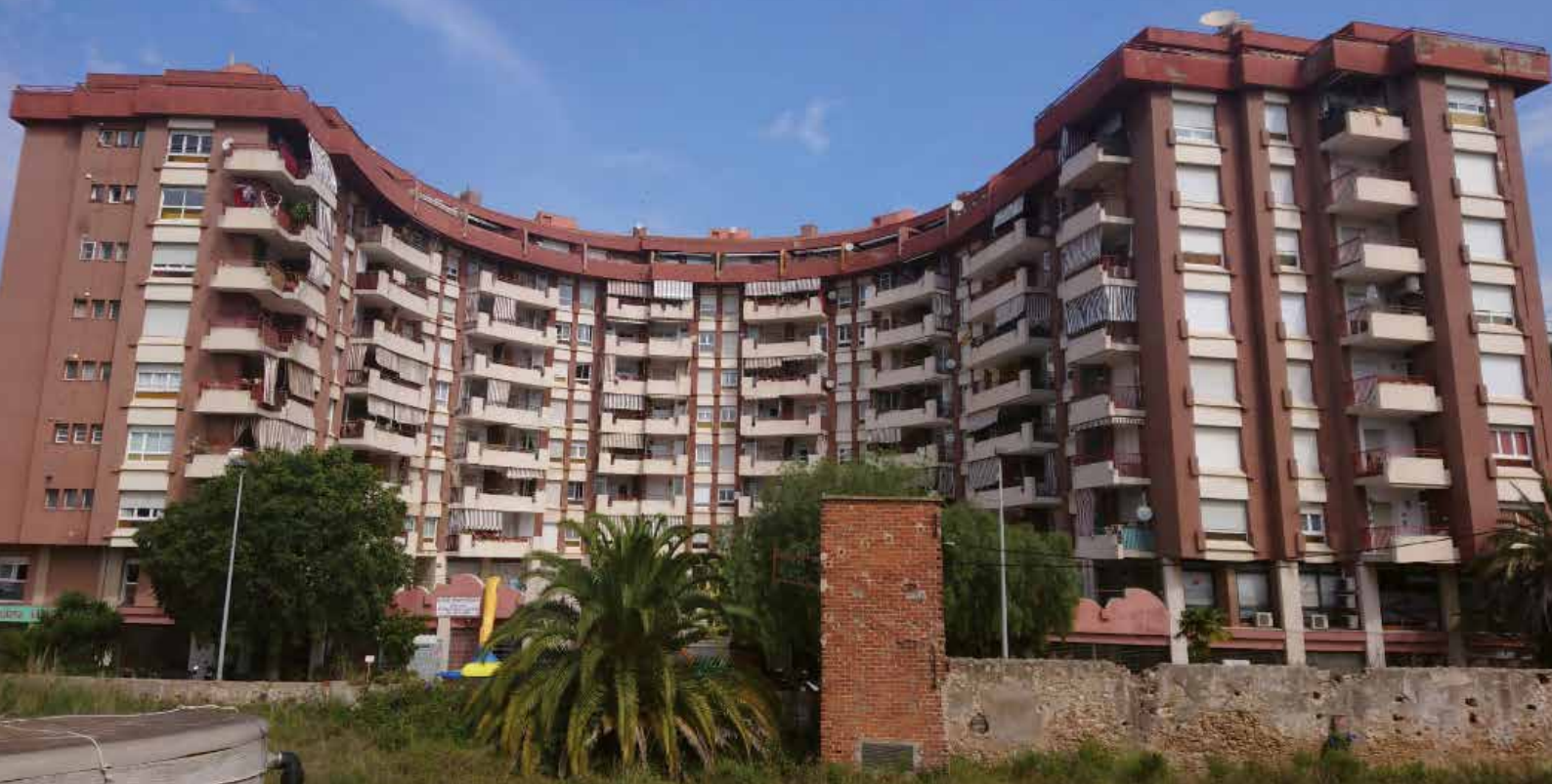
▲ L'edifici Domus Àurea. Fons Jordi Isern (AMBL)
