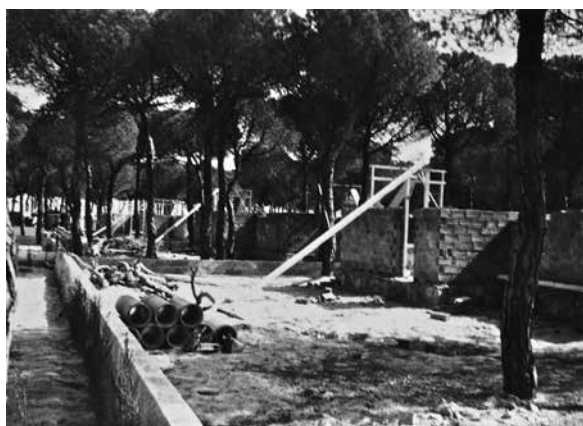
▲ Bungalows en construcció (1962). Fotos: Rolf Auswitz.
