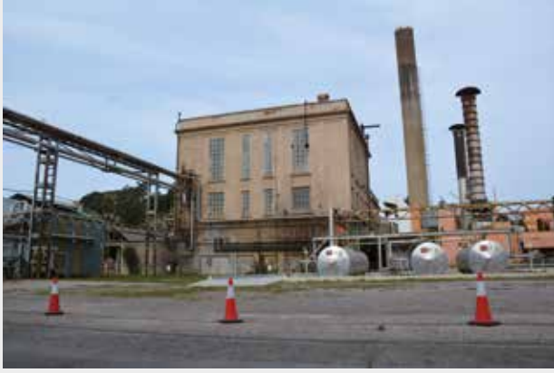
▲ Edifici de calderes i xemeneia gran. 2014 (AMBL)
