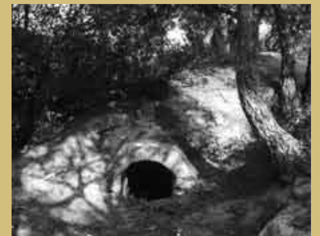
Entrada al niu de metralladores
