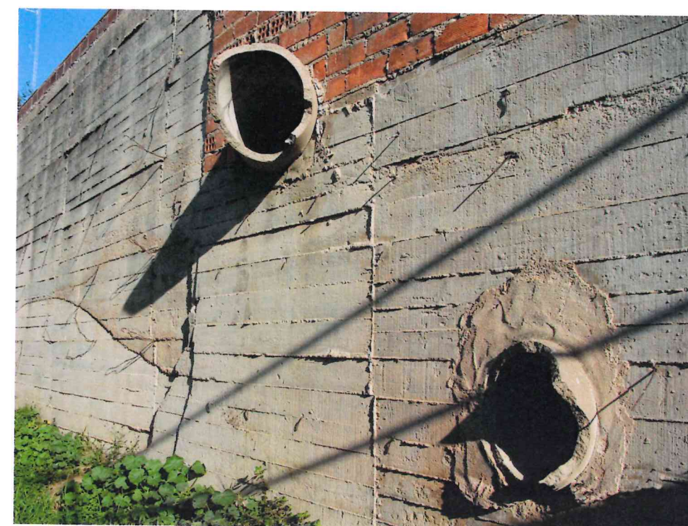
Desguassos existents d'aigües pluvials al canal
