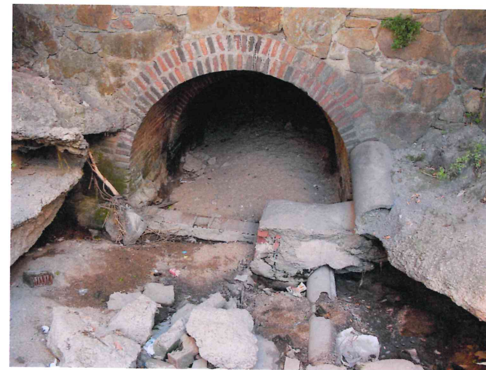
Canalització existent de les aigües pluvials al final del tram del mateix a canalitzar
