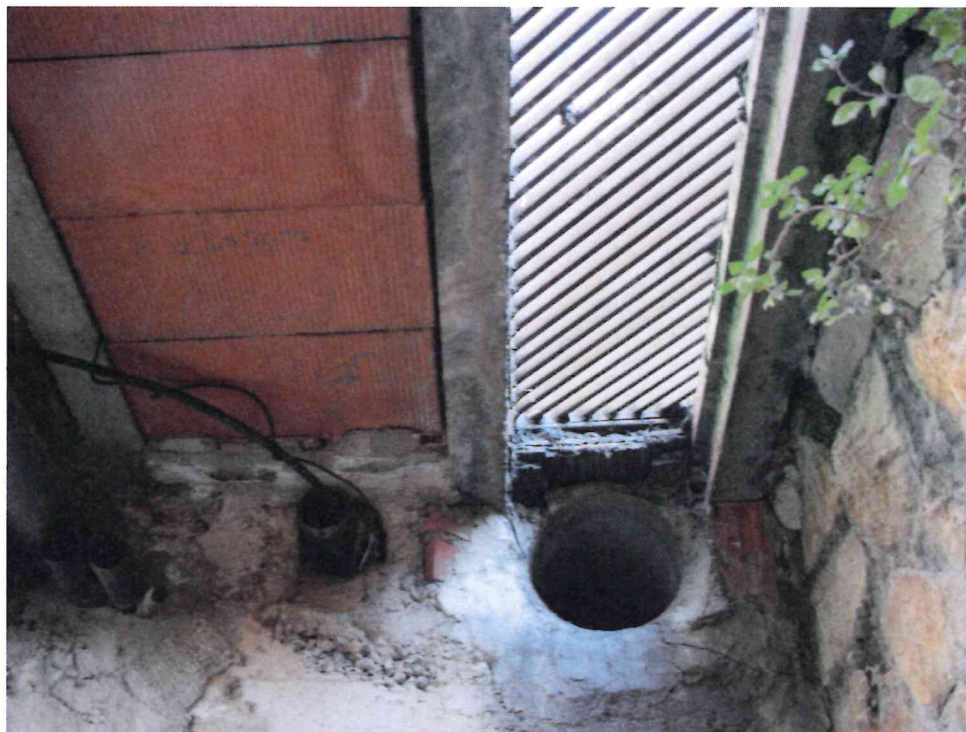
Detall dels serveis i de la reixa interceptora de pluvials en l'avinguda Estació
