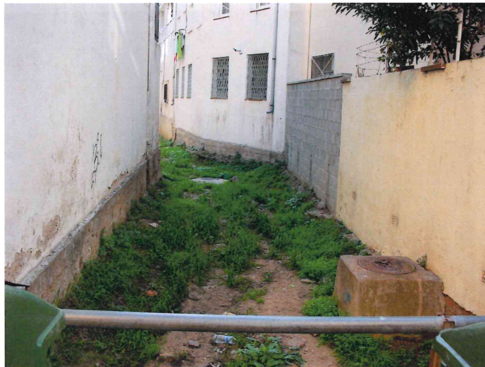
Vista del tram del canal en estat actual des del Carrer Illes Balears
