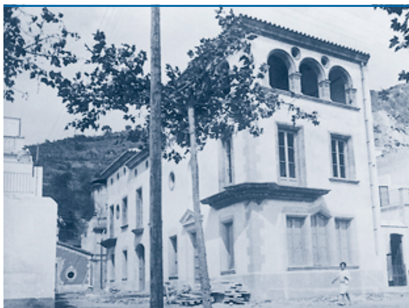
La casa en construcció
