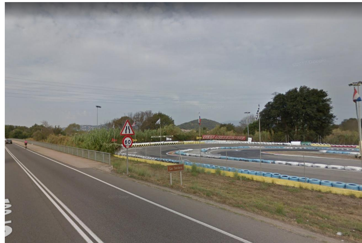
Estat actual de la B-682 i el karting adjacent al projecte en l'entorn d'actuació.
