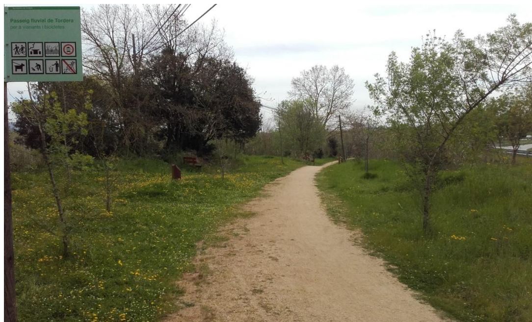
Imatge d'un tram existent del Passeig Fluvial al T.M. de Tordera amb paviment de sauló compactat.
