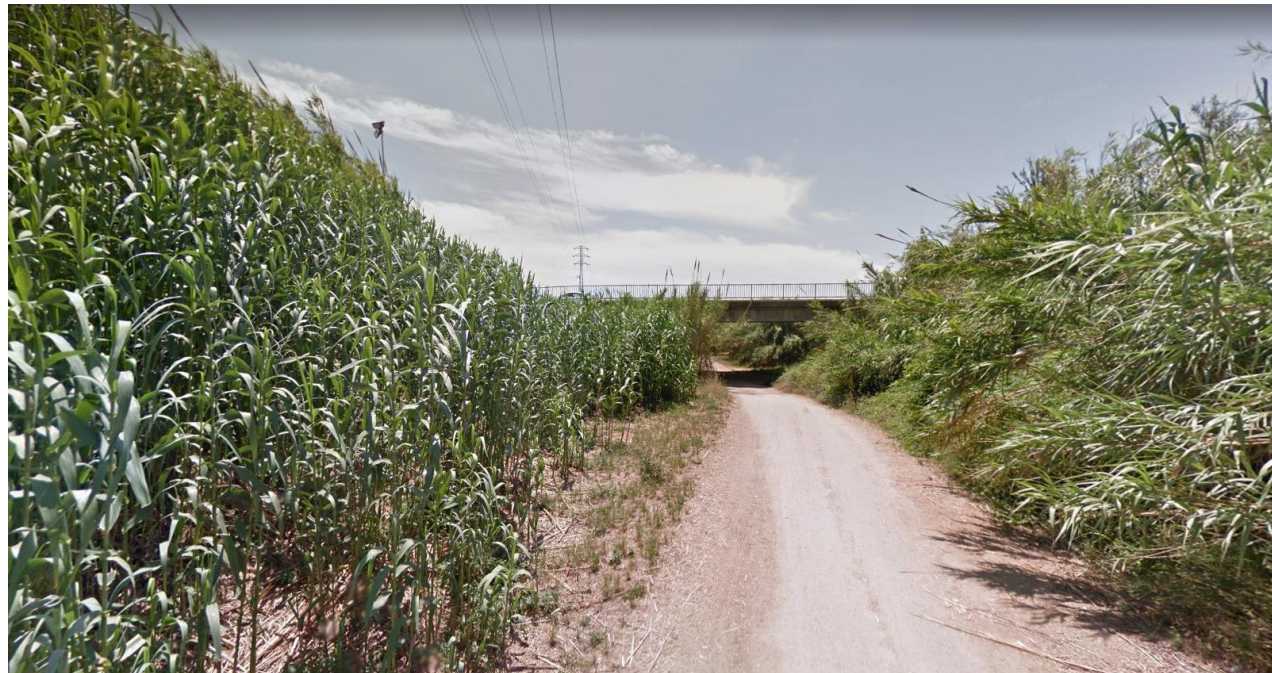
Estat actual del camí existent a les proximitats del pont sobre el riu Tordera.
