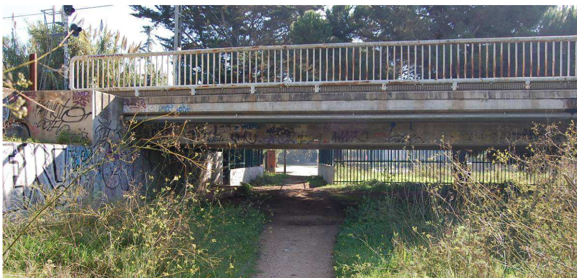
Pas inferior de la ruta per sota les vies del tren a l'enllaç amb l'estació de tren de Blanes
