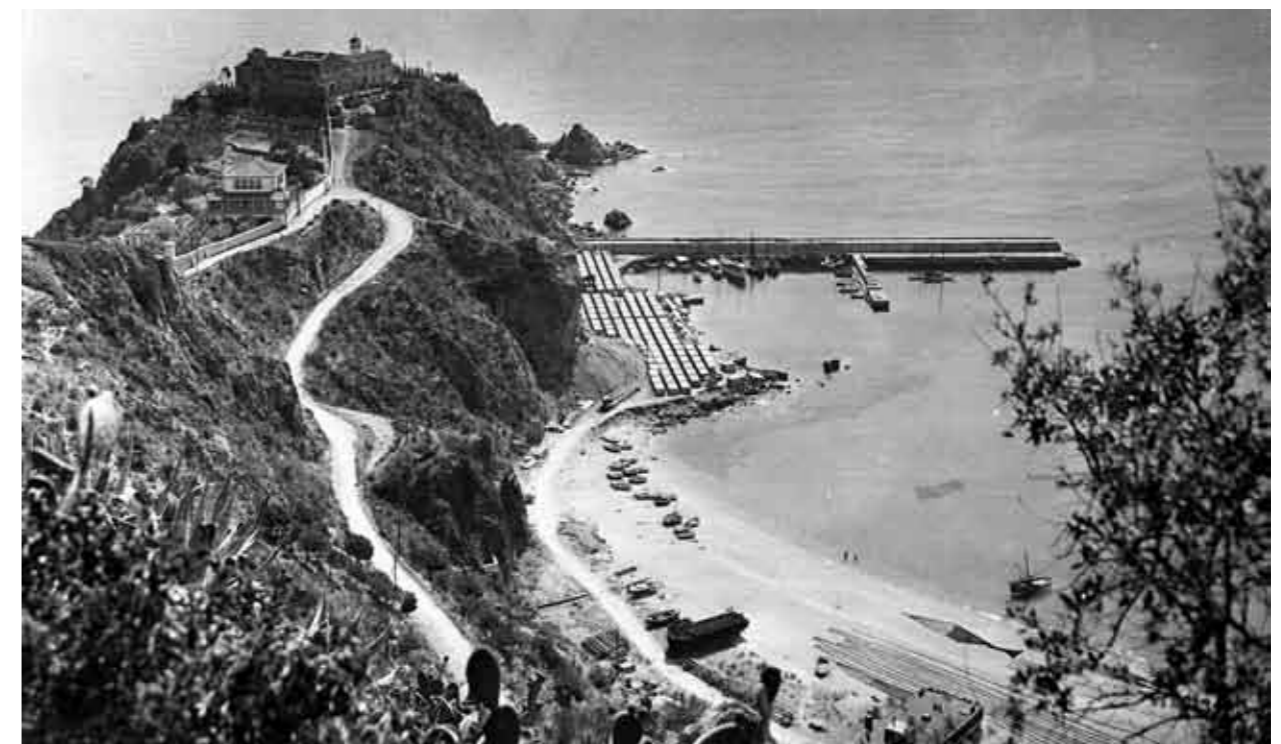
Segona fase de les obres de construcció del port. Primera meitat dels anys trenta. Foto E. Bitlloch. Fons Modern Stil (AMBL)
