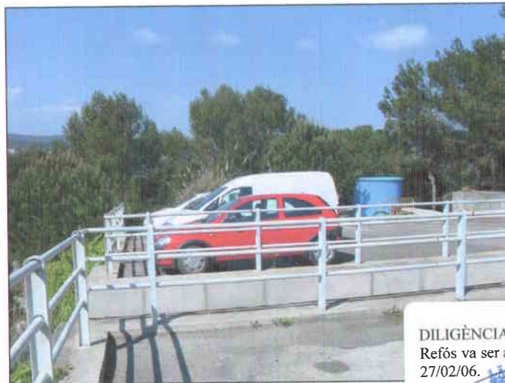
Fotografía 2. Vista norte de la zona de actuación.
