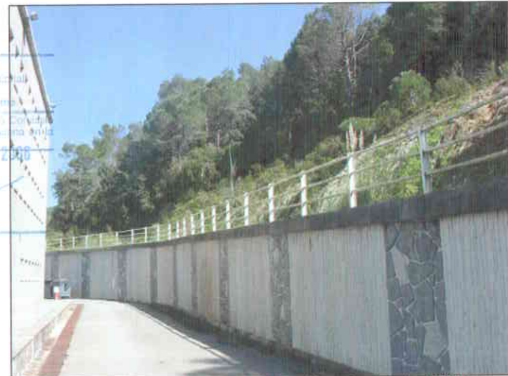
Fotografia 7. Acceso sur a la zona de actuación, rodeando todo el CEAB.
